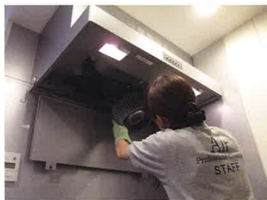
レンジフードクリーニング
